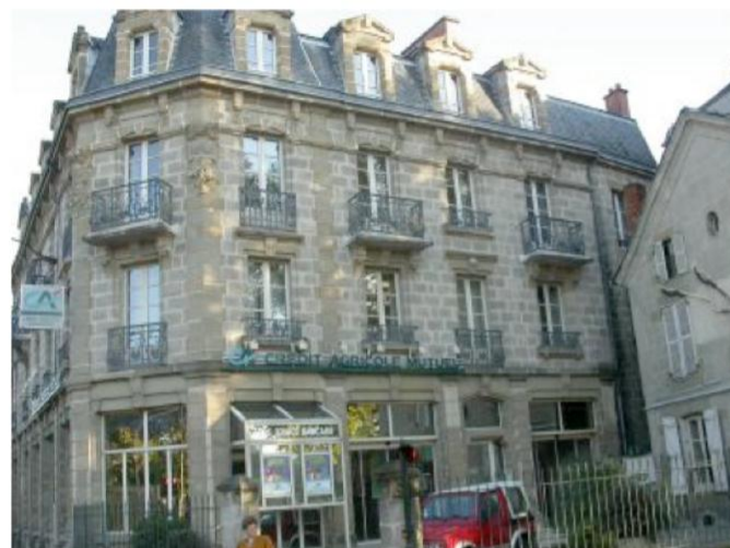
rotonde d'angle, chaînage d'angle et décors en grès fin de Grammont; le reste en brasier. RDC à usage commercial.
