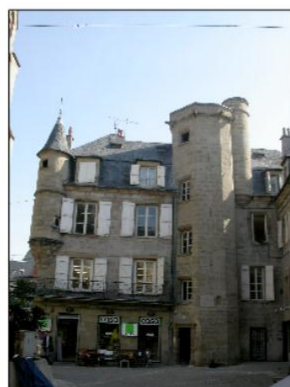
tour d'escalier polygonale, percée d'archères pour la défense, pourvue de gargouilles et se terminant par une terrasse de guet à laquelle on accède par une tourelle secondaire
