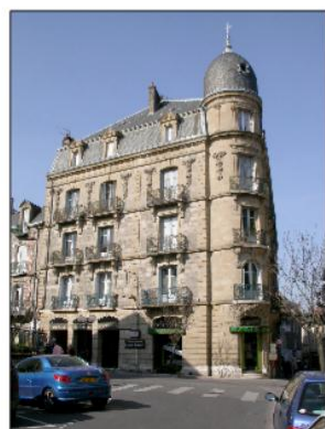
rotonde d'angle, chaînage d'angle et décors en grès fin de Grammont; le reste en brasier. RDC à usage commercial.
